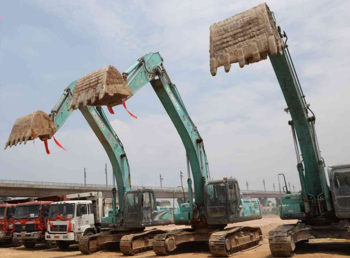
▲开工奠基典礼现场
